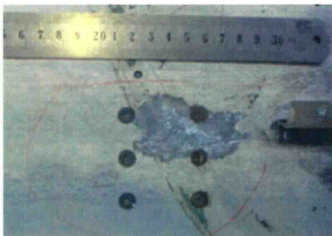
图5-16 铆接处铆钉出现腐蚀
