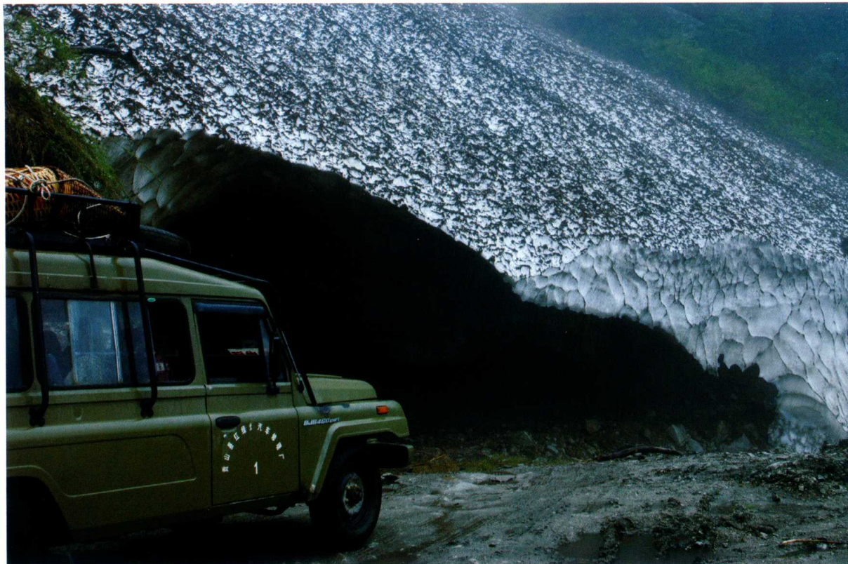
● 独龙江公路上的隧洞（隧洞凿穿冰川而成）
