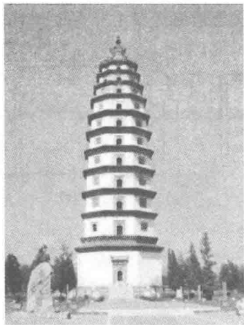
图 1-17 河北定县开元寺塔(料敌塔)
