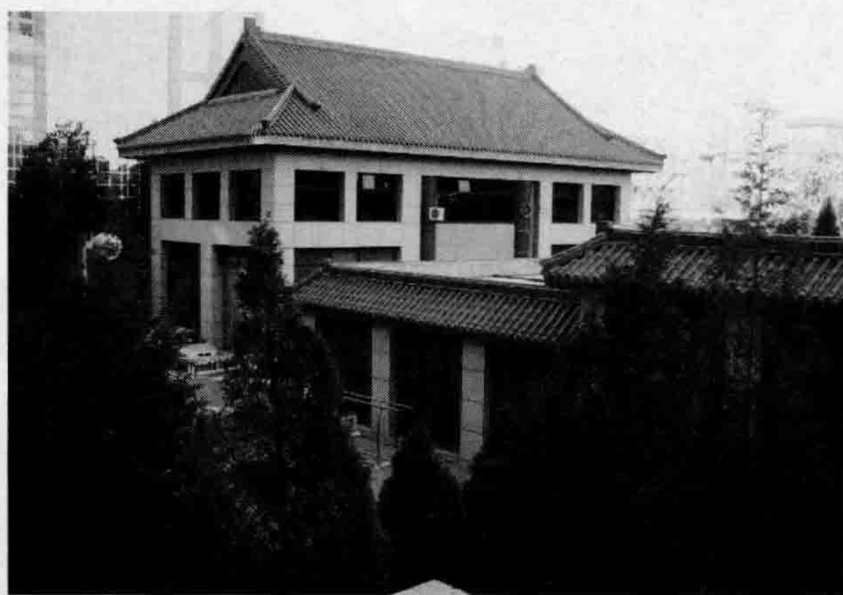
图 1-8 王府井 220kV 变电站
