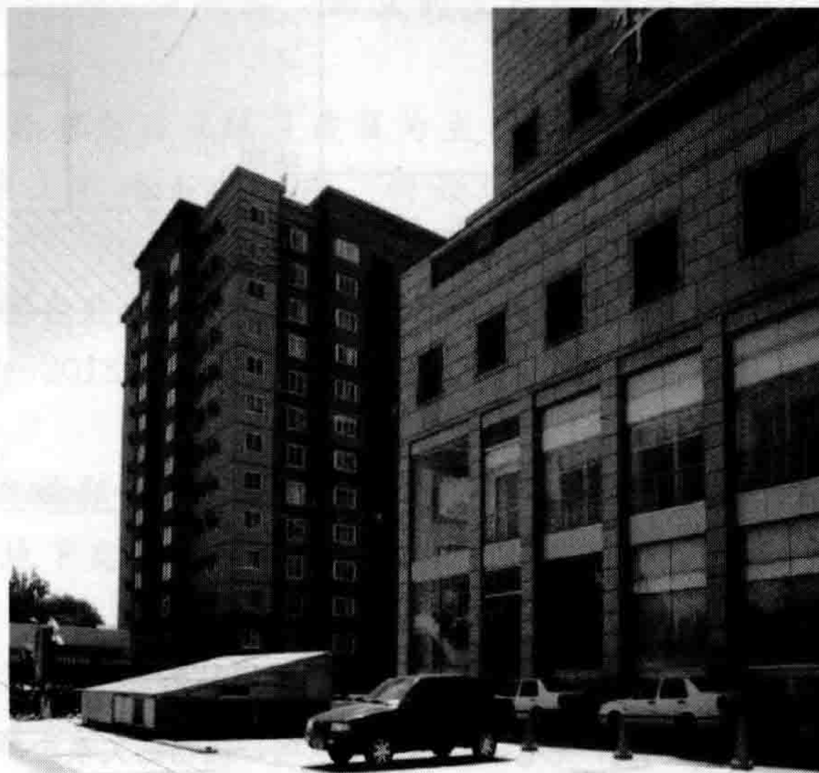
图 1-3 复兴门 110kV 变电站
