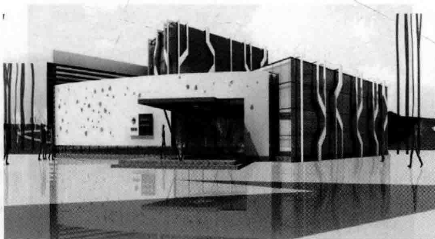
图 1-4 静安 500kV 变电站
