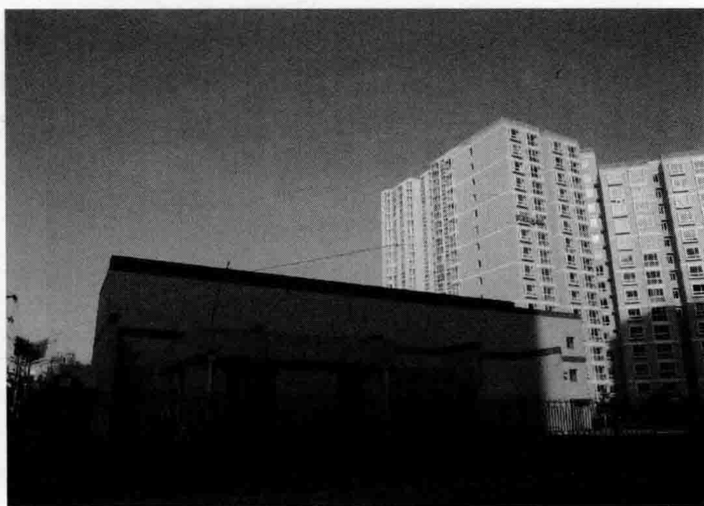
图 1-5 成寿寺 110kV 变电站
