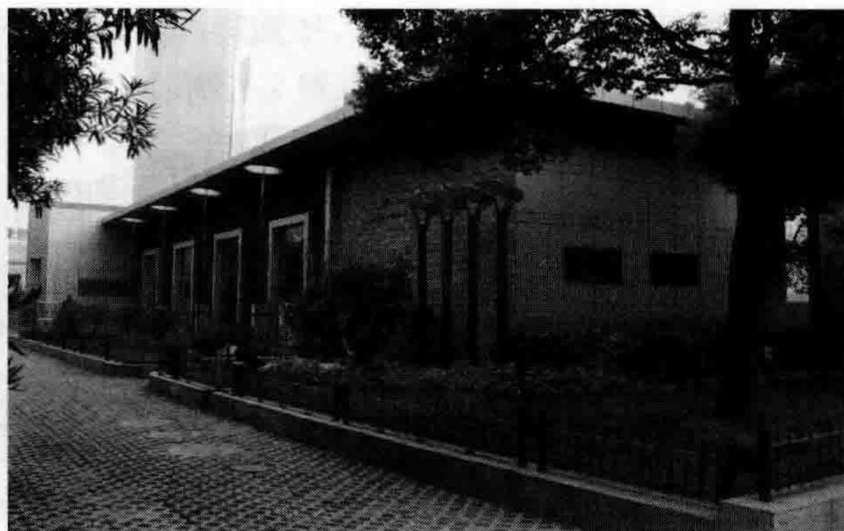
图 1-7 人民广场 220kV 变电站
