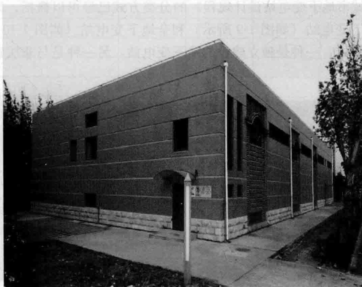
图 1-6 兴隆 110kV 半地下变电站
