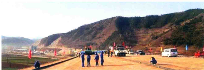
图1-6 基层表面清理
