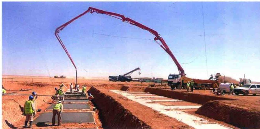
图1-9 浇筑混凝土
