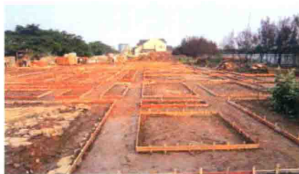
图1-7 浇筑前进行放线支模
