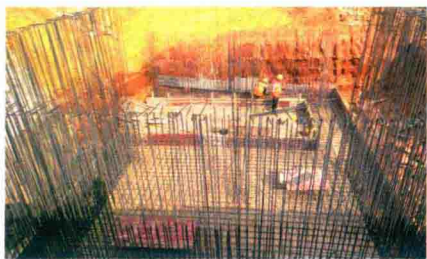
图1-12 剪力墙钢筋绑扎
