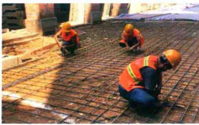
图1-13 道路基础钢筋绑扎
