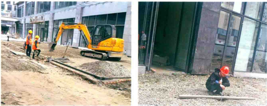
图1-5 级配砂石垫层分层铺筑
