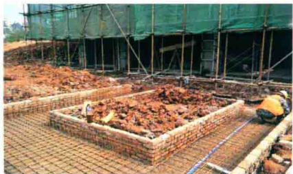
图1-14 水景池底钢筋绑扎
