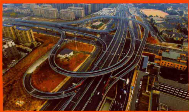
2017年12月30日,紫金港互通立交工程新增西向北、西向南两个方向匝道及其连接主线开通运行(李忠摄)
