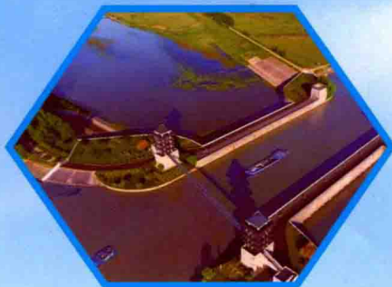
淮安“水上立交” ——亚洲规模最大的水上立交工程
