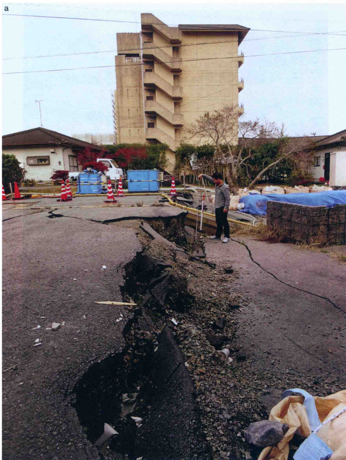
插图 4 阿苏破火山口内内牧温泉町出现的同震地表破裂断层坎。(a)横跨在地震断层坎上的宾馆大楼。虽然受到破坏,但震后至今还在营业。(b)横跨在断层坎上的民房被破坏。
