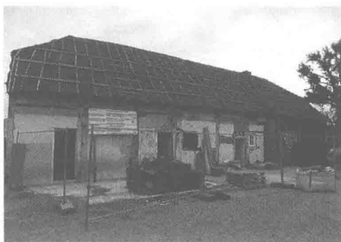
图1 建筑后立面（2013年）
