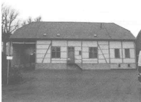
图3 保护修缮工程后的前立面呈现样貌
