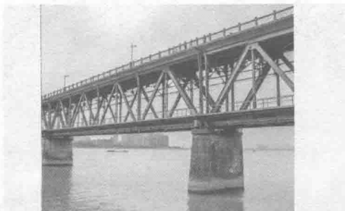
图 1-11 杭州钱塘江大桥
