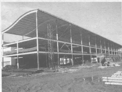
图 1-10 多层厂房钢结构
