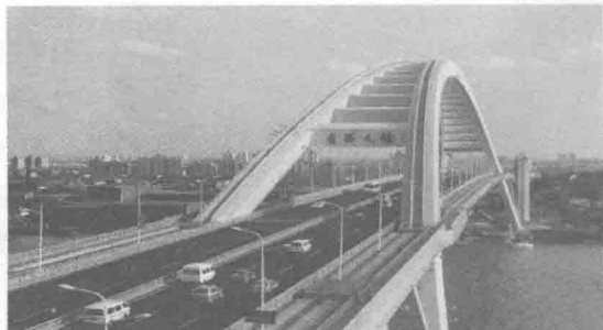
图 1-12 上海卢浦大桥
