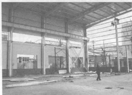
图 1-9 单层厂房钢结构
