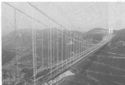
图 1-13 矮寨特大悬索桥
