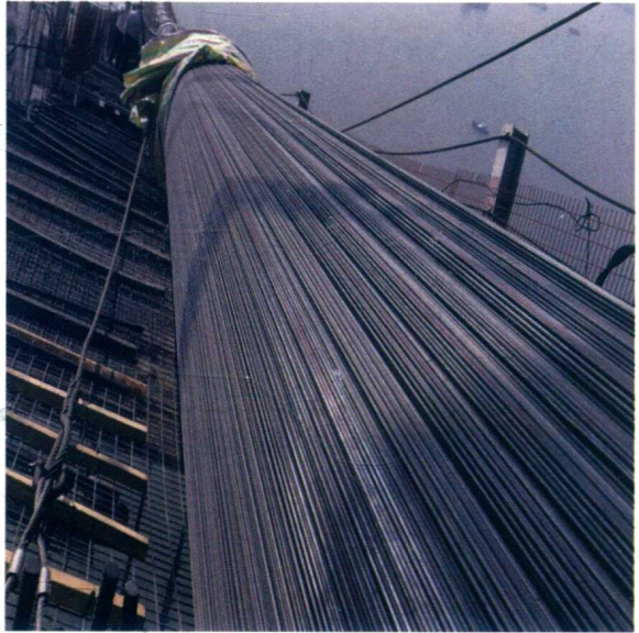
建设中的虎门二桥主缆钢丝
