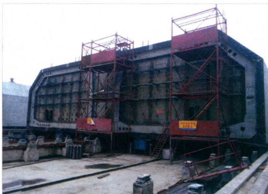
建设中的港珠澳大桥隧道沉管
