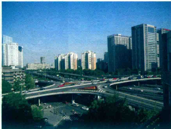
图1-1-11 成都人南立交桥（邱建拍摄）
