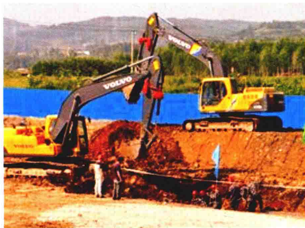
▲ 长沙3年将建63公里地下综合管廊
