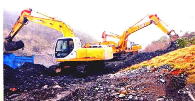
▲ 湘潭锰矿区矿山地质环境治理示范工程施工现场
