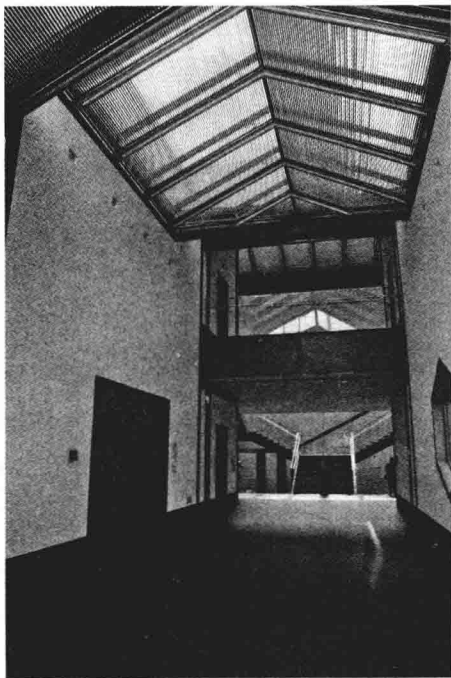
图 1-3 苏州博物馆的廊道
