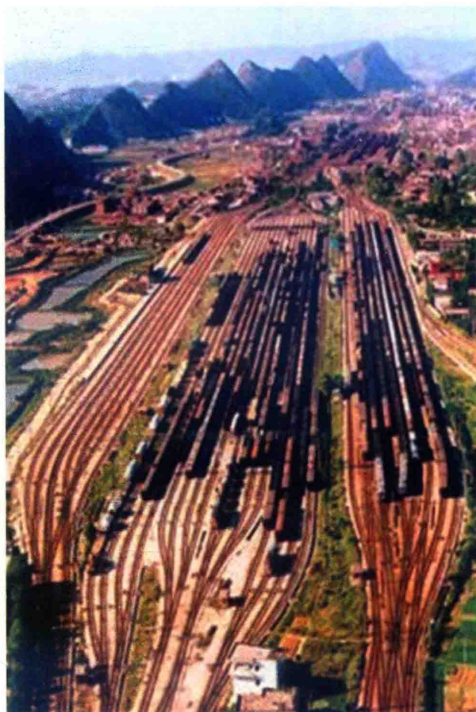
2010年1月25日,西南最大的铁路枢纽编组站——贵阳南站改扩建工程全面竣工投入运营
