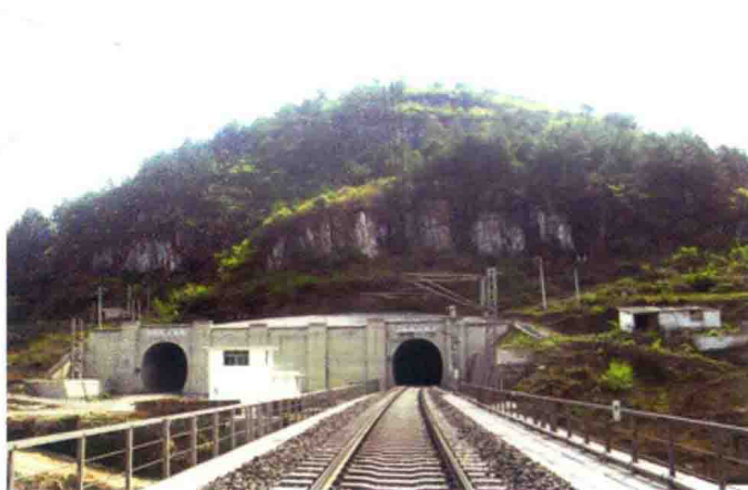
2009年投入运营的定水坝隧道,为黔桂铁路全线最长隧道,全长8540m（左洞为预留线）
