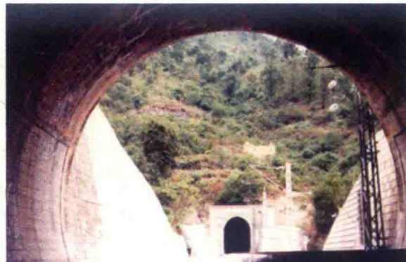
2002年，内昆铁路隧道群
