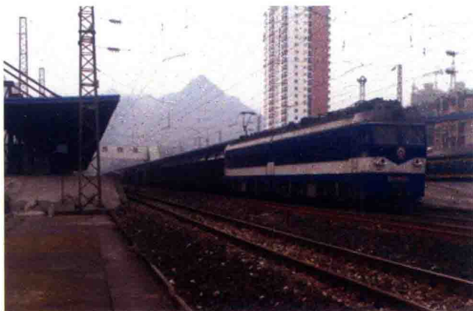
2009年1月10日,黔桂铁路扩能改造全线建成并投入运营,省内铁路干线全部实现电气化
