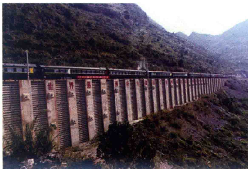
1996年建成的南昆铁路石头寨车站预应力锚拉式桩板墙，誉称“亚洲第一墙”
