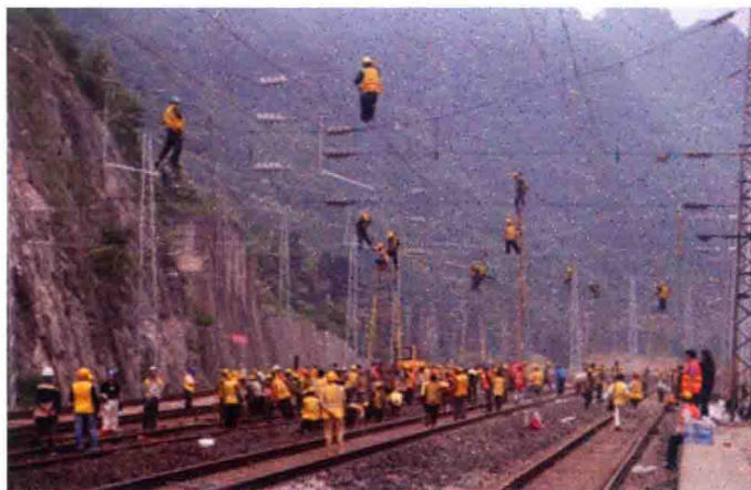
2007年7月15日，沪昆铁路最后一段复线——六（盘水）沾（益）复线开工建设。图为双水车站站场改造情景
