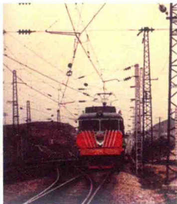
1985年，贵州第一条电气化铁路——贵昆线贵阳至六盘水段通车
