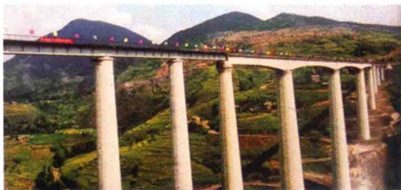
2002年，内昆铁路花土坡大桥
