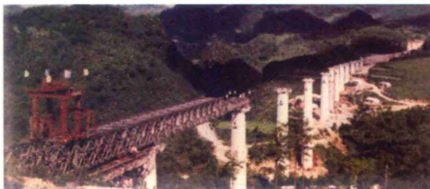
2000年建设中的株六复线新响琴峡大桥
