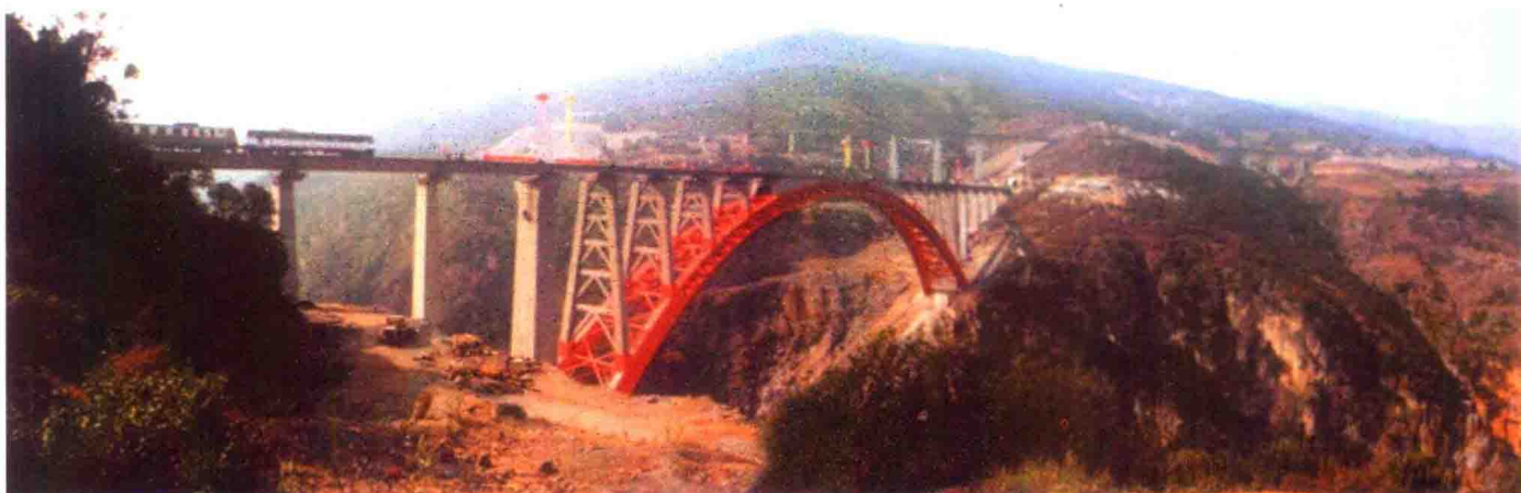
2001年11月建成的世界上跨度最大的单线铁路钢管混凝土拱桥——水柏铁路北盘江大桥
