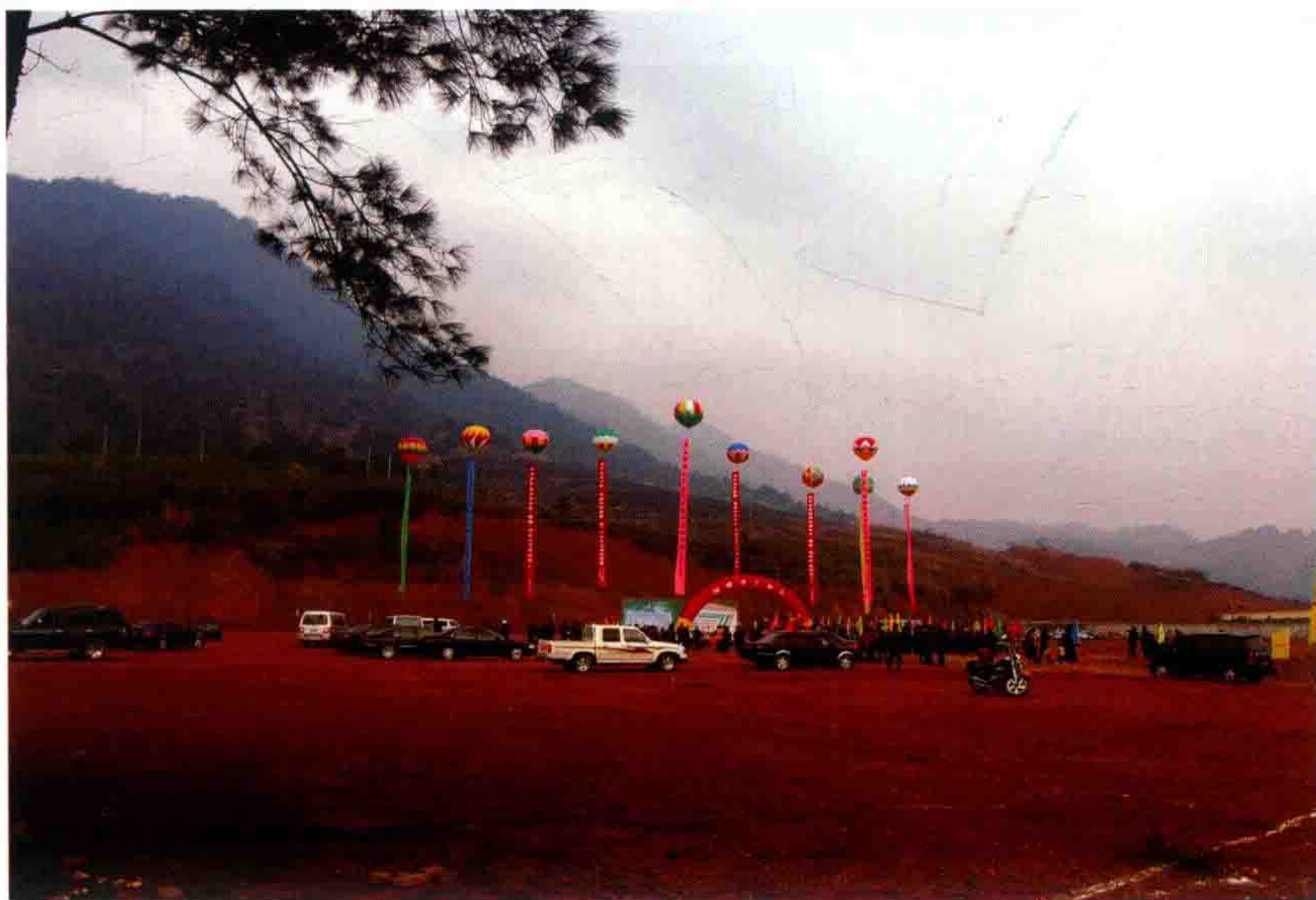
2005 年 2 月，北郊工业园区一期工程开工建设
