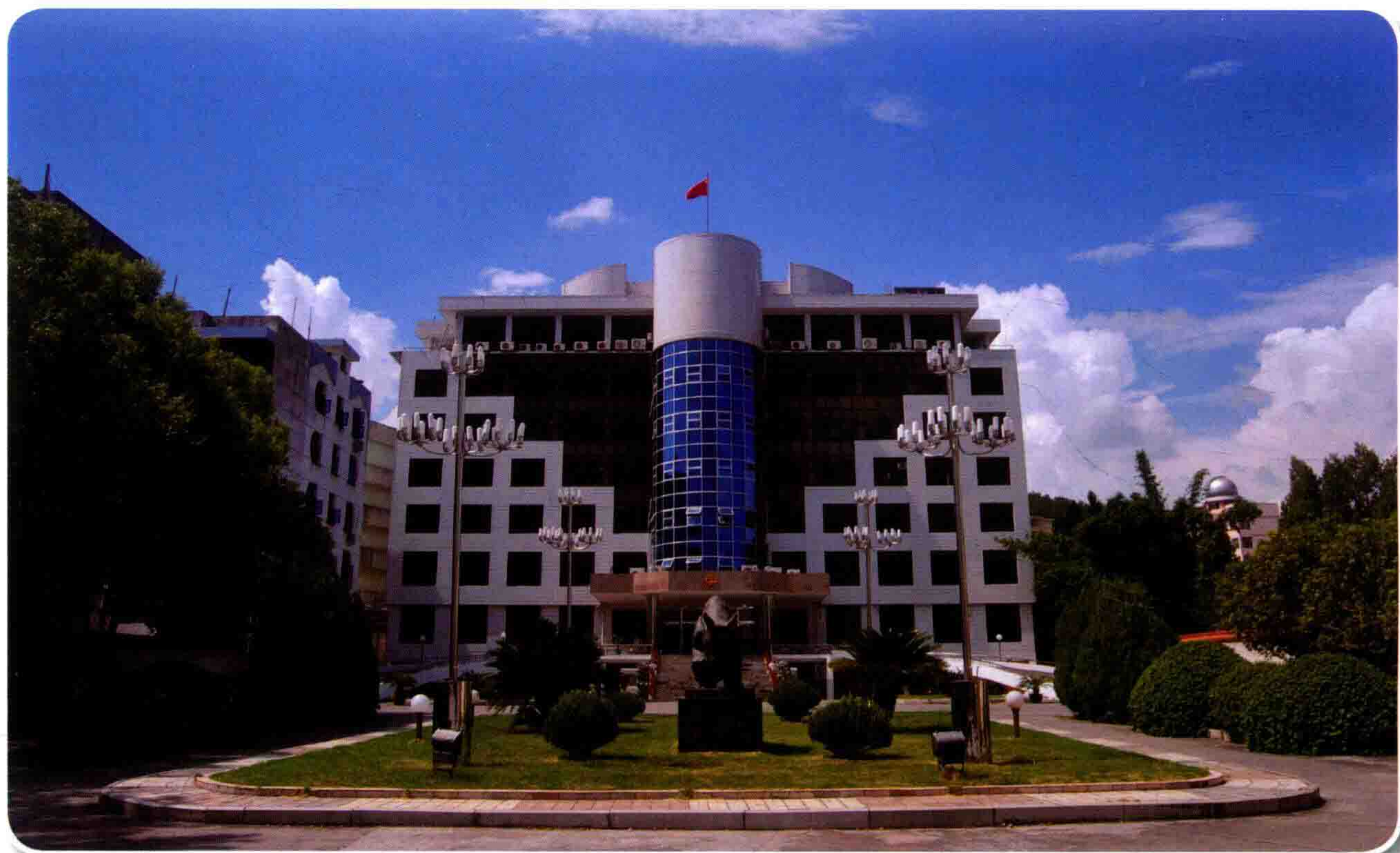
1995 年竣工的县政府办公楼 (2005 年摄)
