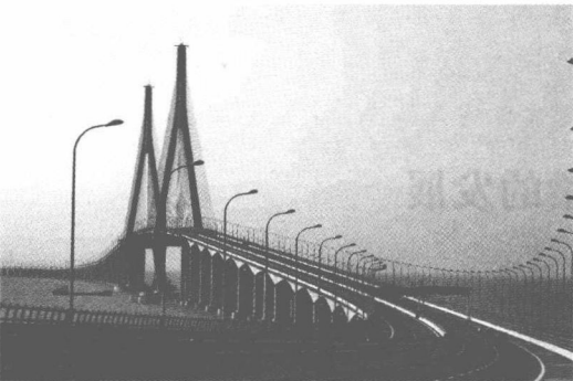
图 1-2 杭州湾跨海大桥
