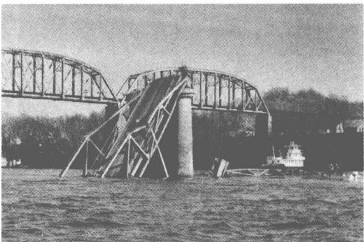
图 1-6 Silver Bridge 垮塌事故
