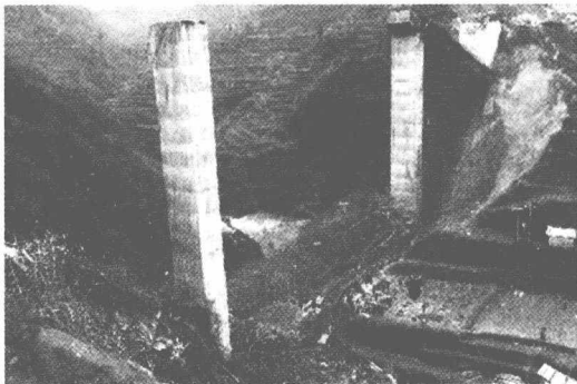
图 1-10 贵州小尖山大桥垮塌事故
