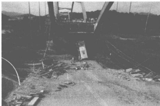
图 1-12 福建武夷山大桥垮塌事故
