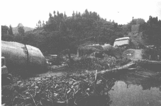
图 1-9 湖南堤溪沅江大桥垮塌事故
