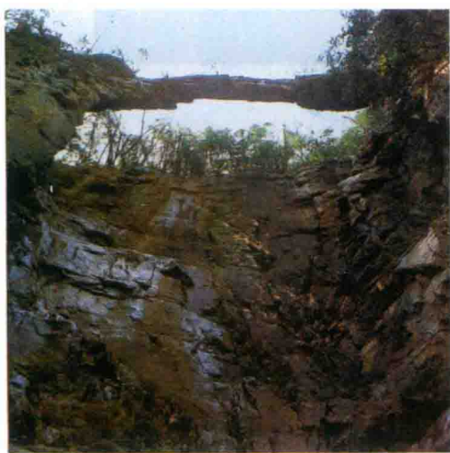
照片13 仙人桥：桥宽、桥厚各1余m， 跨度20余m，凌空150 m
