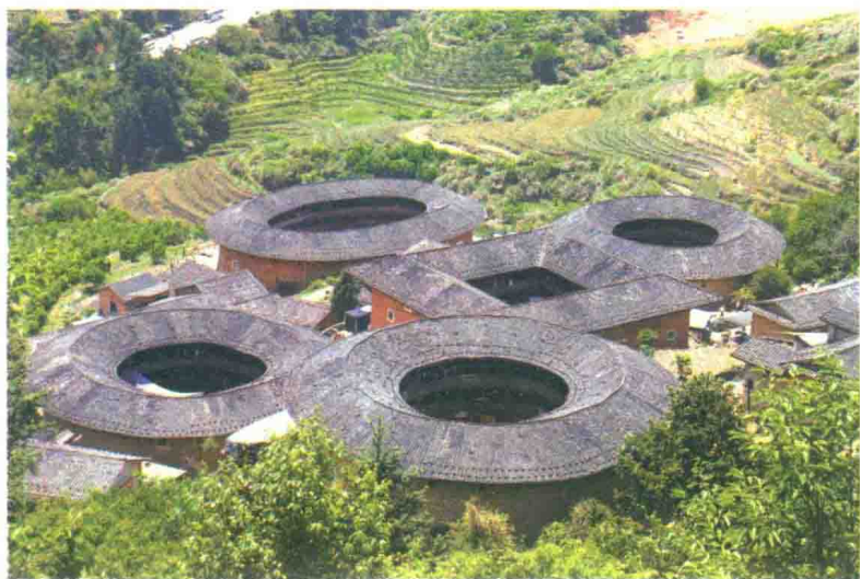
福建土楼人家
