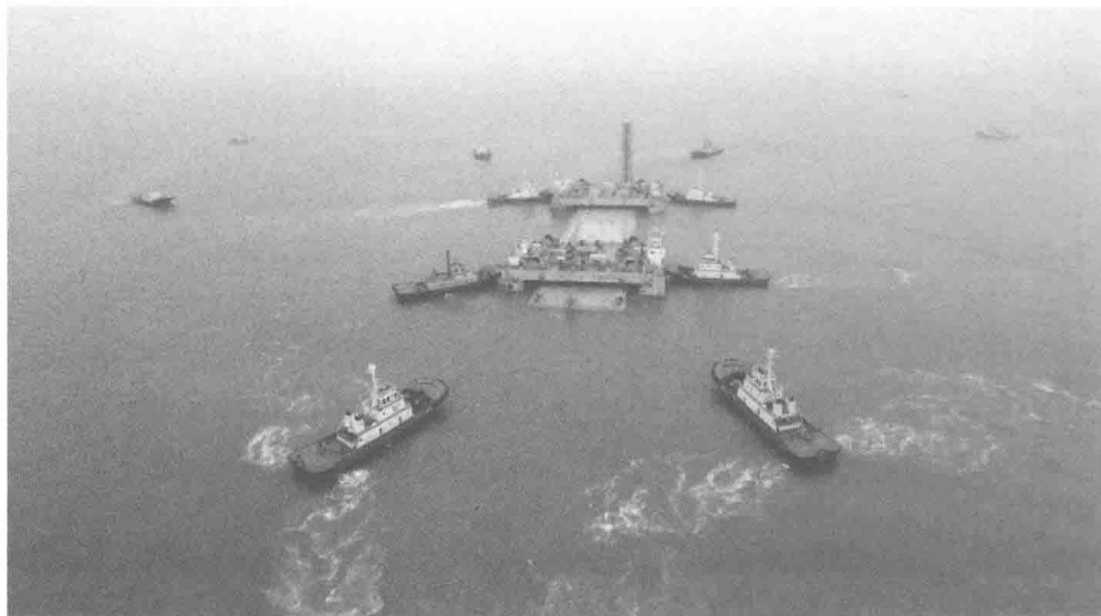
图 1-7 港珠澳大桥沉管隧道工程管节拖航
