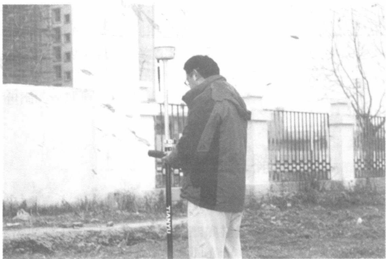
图 1-7 北斗导航施工放样
