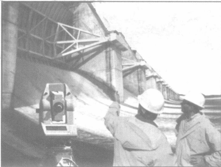
图 1-3 桥梁梁部偏心测量
