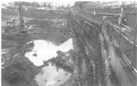
图 1-4 地下连续墙施工现场照片
