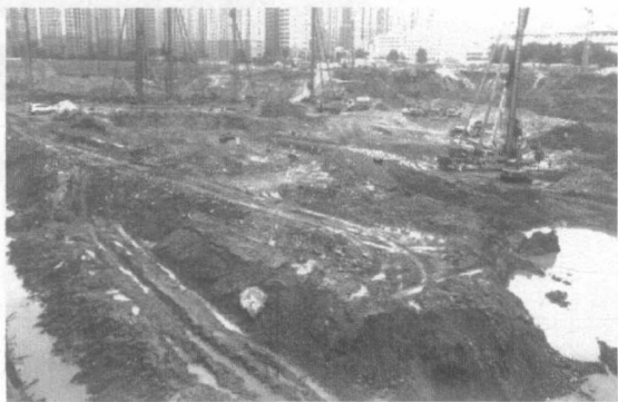
图 1-1 基坑施工照片
