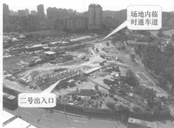
图 2-2 施工场地现状图
