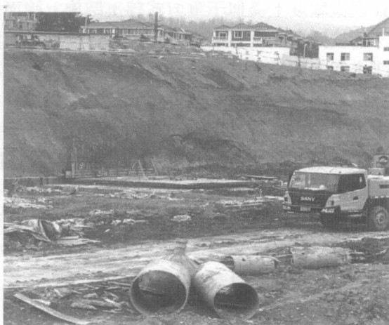
图1-3 无支护放坡开挖
