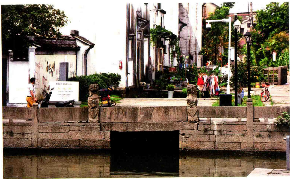
永兴闸排水口
