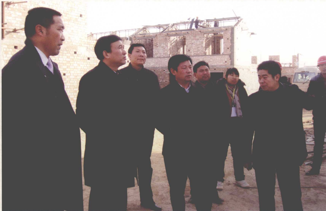
2010年12月，河南省南水北调移民安置指挥部办公室副主任王小平（左二）在郑州市移民新村工地检查工作
