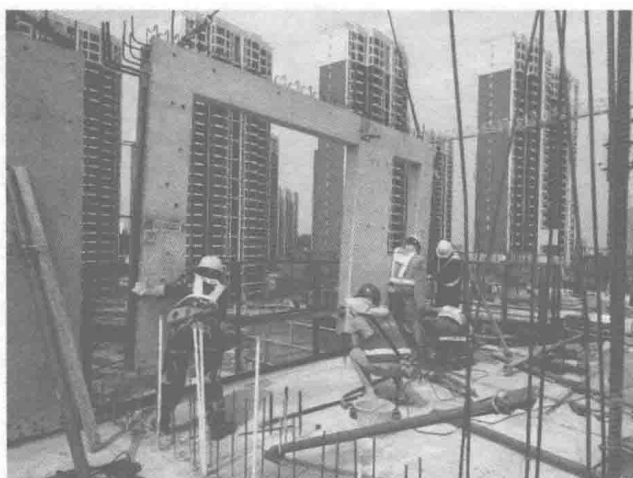
图 1-5 预制构件吊装
