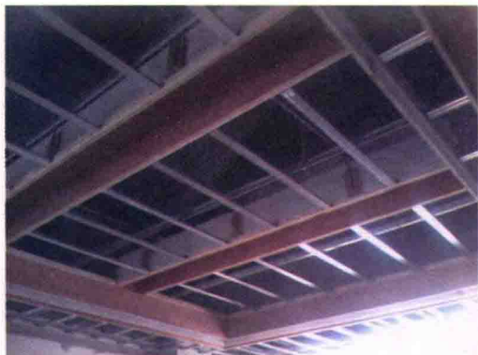
图2-1-4 天棚吊顶构造
