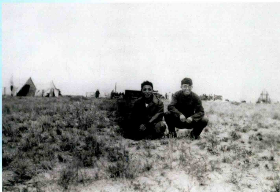
1954 年刘建章在集二线施工现场调研
