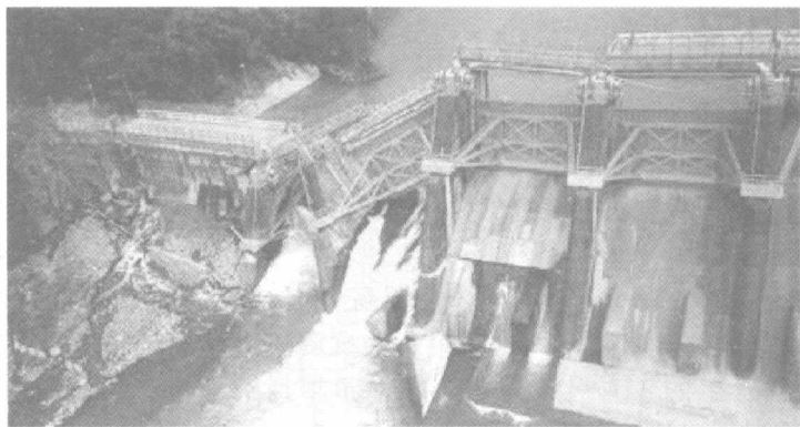
图 1.4 石冈坝由于断层错动破坏的闸孔
