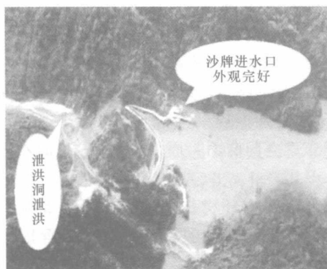
图 1.8 汶川地震后的沙牌拱坝
