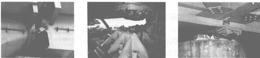
(c) 连梁装置连接板拉断或锚栓拉伸破坏等
