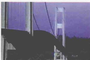
1940.11.7 塔科马大桥坍塌
