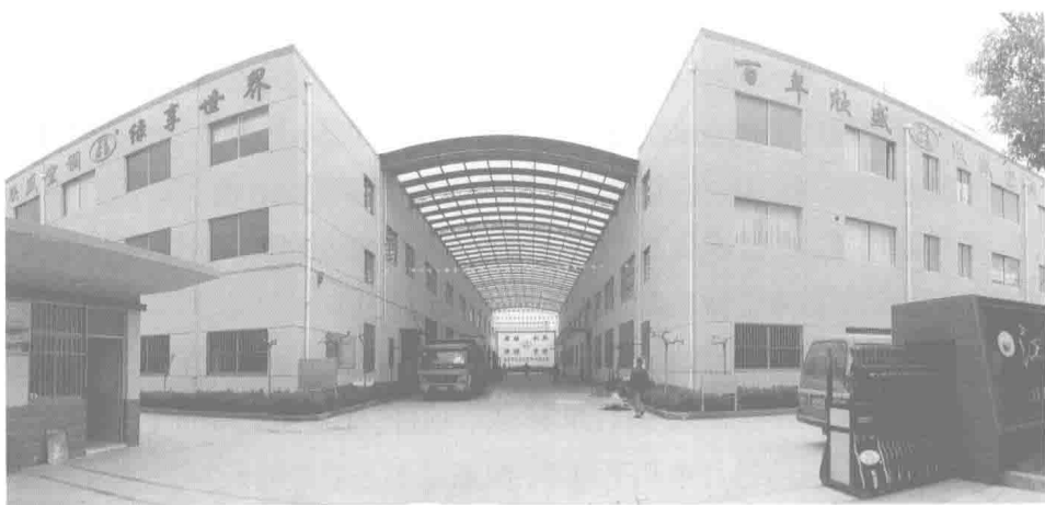
欣盛空调厂房外景
