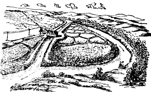
图1—1—7 渠道引水式水电站
