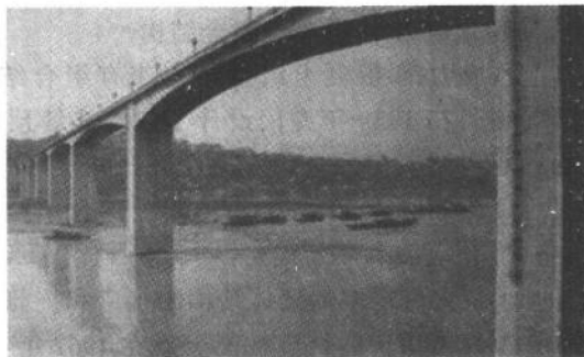
图 1-9 预应力刚构桥
