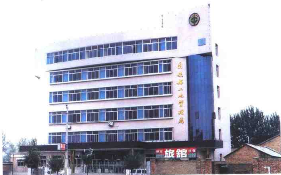
▲ 固安县土地管理局办公楼
