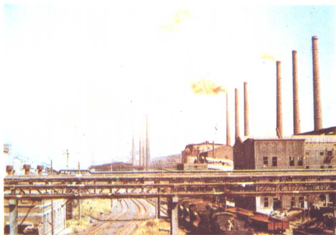
使用消烟除尘装置的烟囱和没有 使用消烟除尘装置的烟囱的对比
