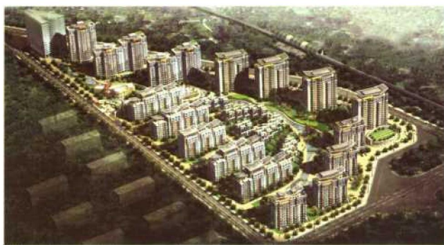
图 1-9 北京上地佳园住宅小区
