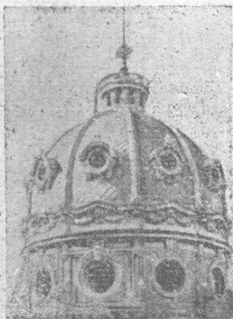
圖 5 凸鱗狀石棉水泥板的 圓屋面
