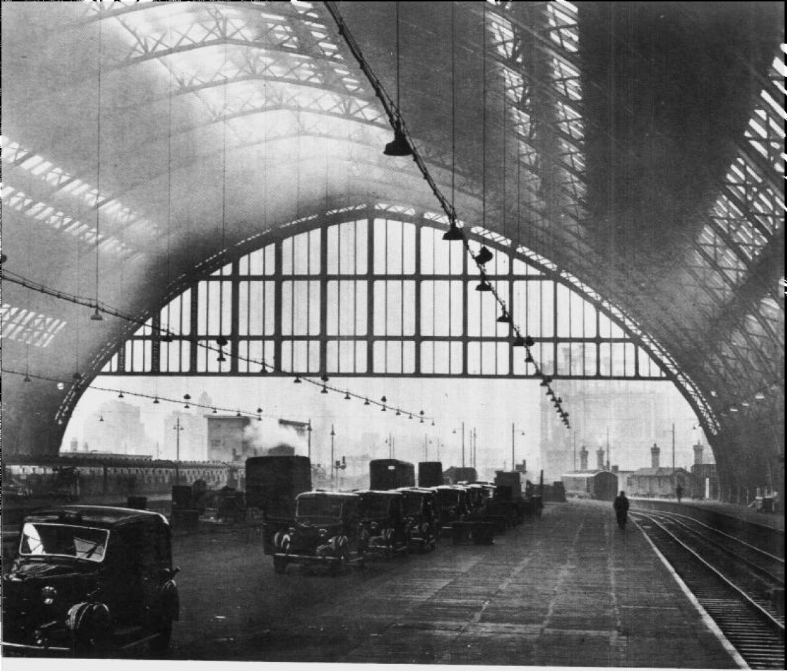
006 | W·H·巴罗于1864年设计的伦敦圣潘克拉斯车站的火车车库：跨度为74米的尖顶拱门不啻一项工程学伟绩。
