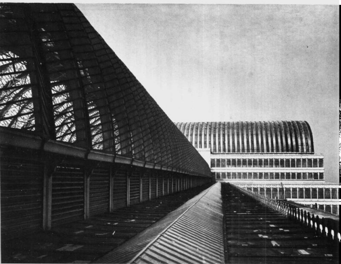
001 | 水晶宫,为 1851 年大博览会而建,1853 年重建于锡德纳姆山 [Sydenham] (上图,沿着屋顶可以看到“袖廊”)。由约瑟夫·帕克斯顿 [Joseph Paxton] 设计,全部采用预制构件组装,标志着对建筑中历史风格 [historical style] 的首次重大突破。
