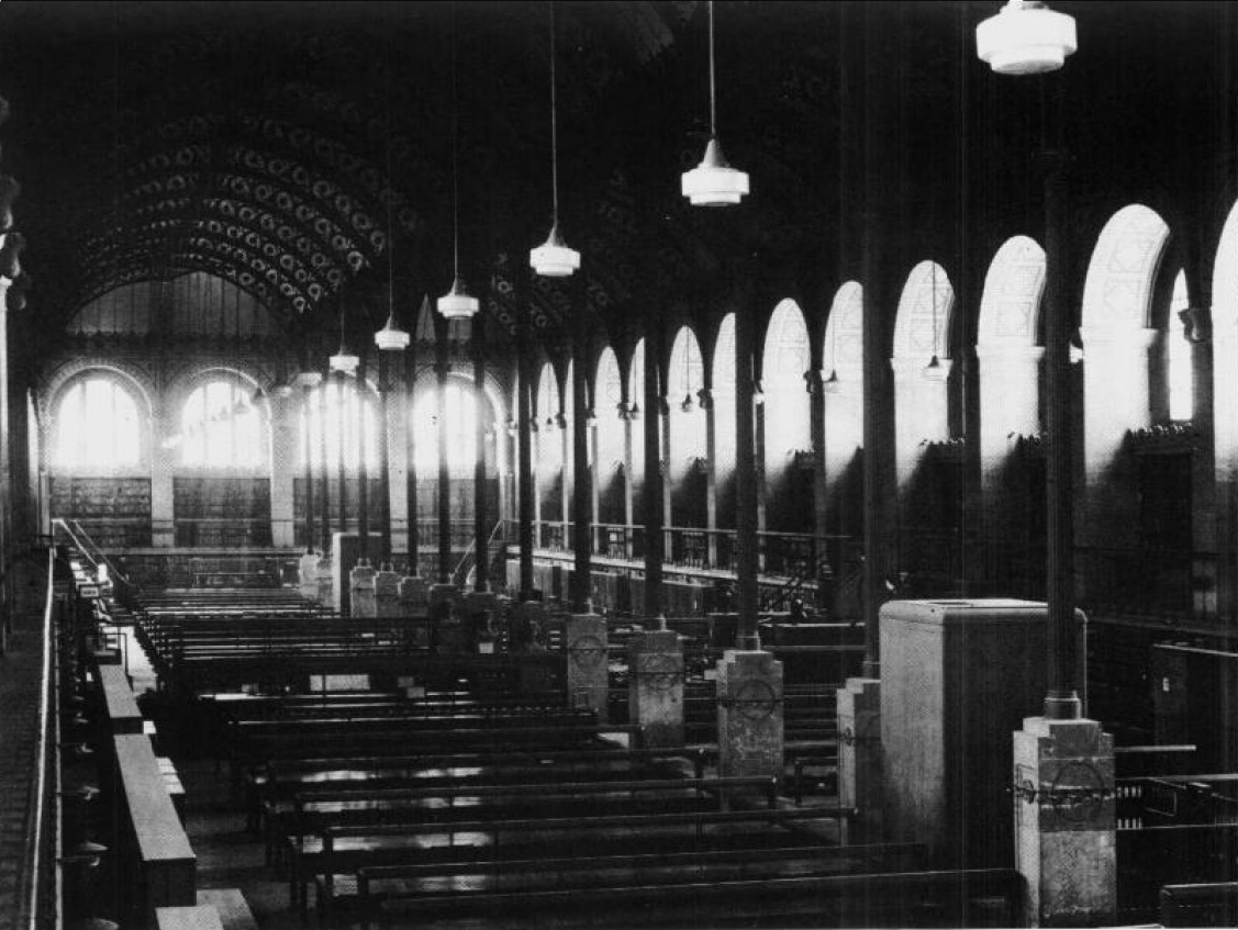
005 | 巴黎圣-热纳维耶图书馆，由亨利·拉布鲁斯特设计于1843—1850年，它公然显露铁框架结构。当时，铁框架一般覆以石料或者灰泥。
