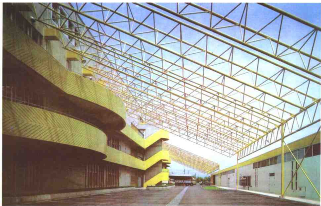
奈良味噌厂 新旧建筑之间的钢桁架(日本)
