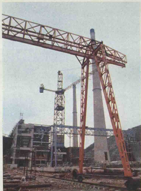
台州发电厂二期 工程在建设中
