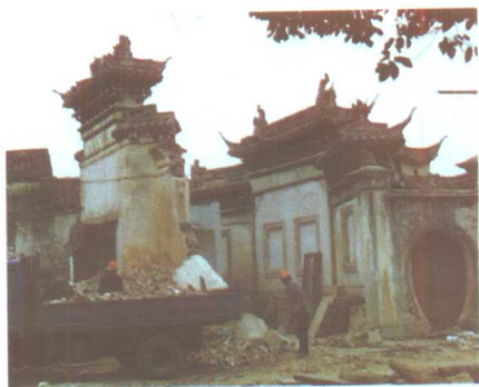
正在拆毁的古建筑
