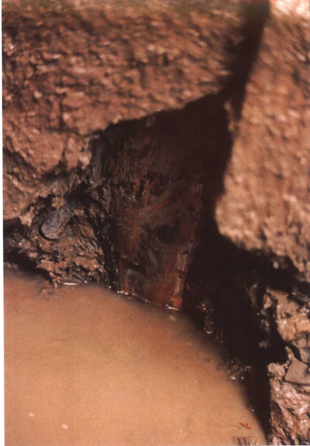
▲ 桥墩下木桩基
