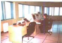
VTS 监控室 VTS control room
