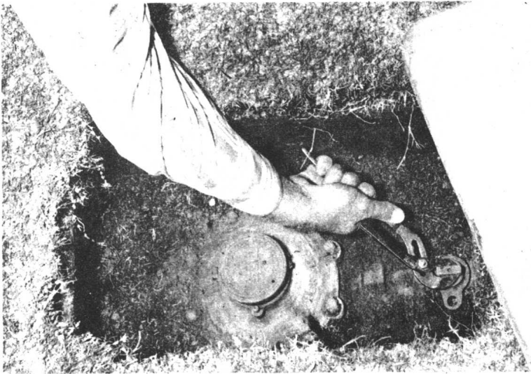
圖 1-6 另一具停止閥，位於房子的外側，必須以鉗子來啓閉
