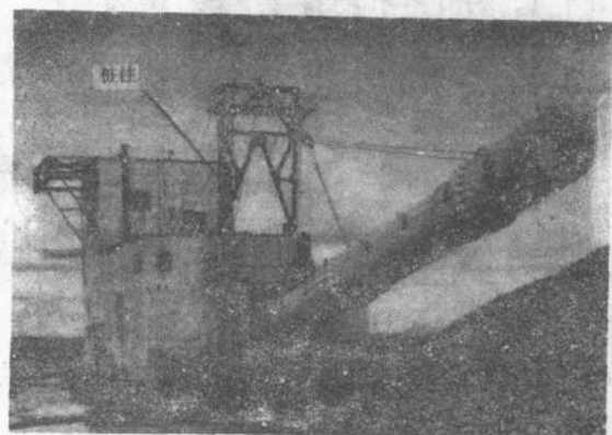
图5 桩柱式采金船
