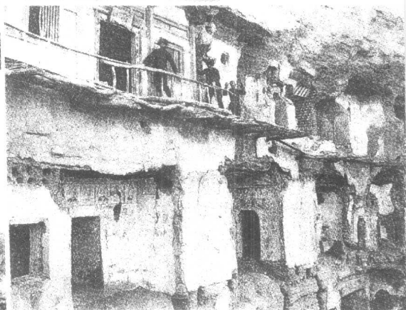
塌毁的栈道(1908年)
