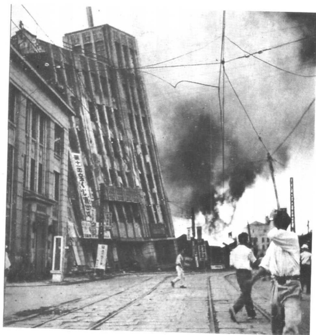
图为地震中一幢楼房倒塌的瞬间。
