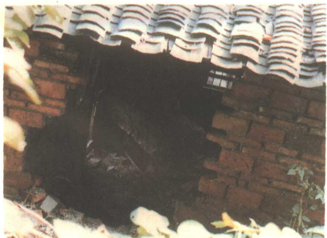
图版16 1984年8月2日鸛鹑山崩塌，房墙打穿，崩塌岩块跳入房内
