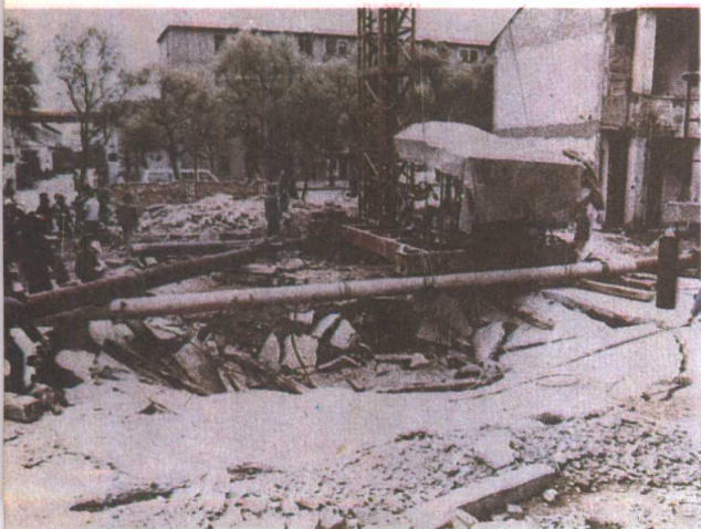
图版 11 桂林市中山南路 403 地质队震动和加载 引起的塌陷
