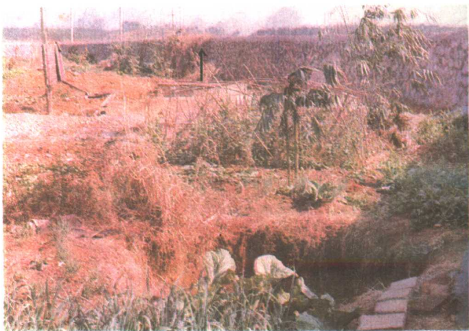
图版 10 桂林市东郊二药厂大门围墙内水井抽水发生 多处塌陷（箭头处为抽水井）。距水井18 m， 圆形，直径3 m，深2 m
