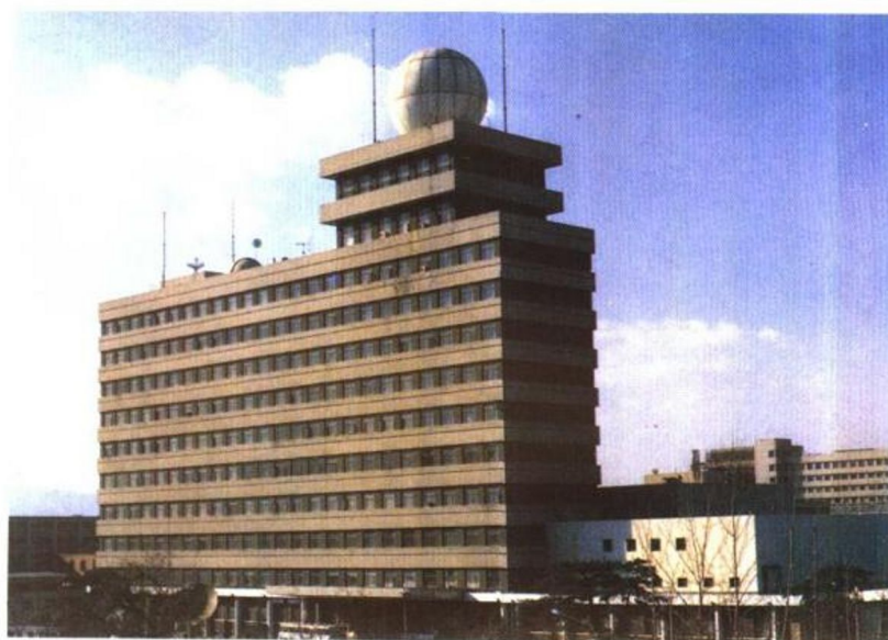
· 国家气象卫星中心大楼
