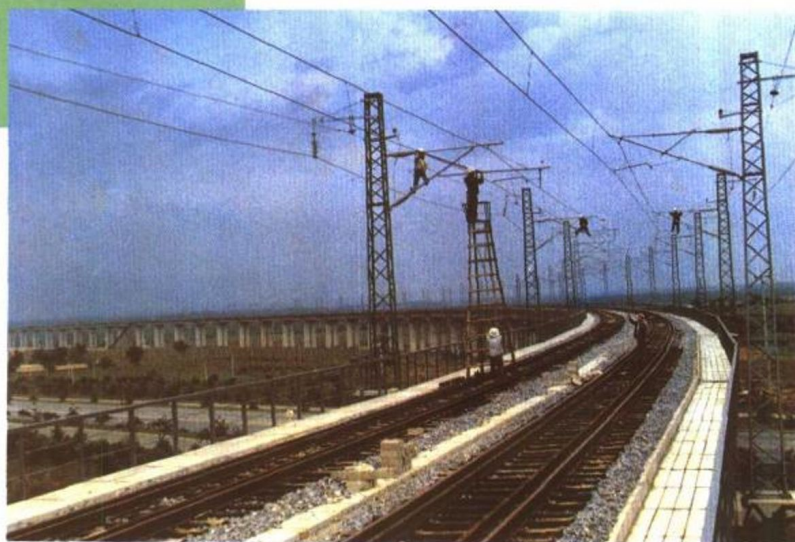
大秦线重载列车电气化工程
