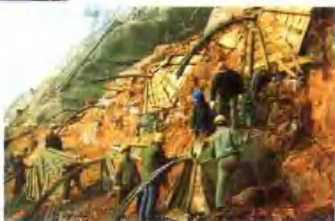
高边坡锚索群安装
