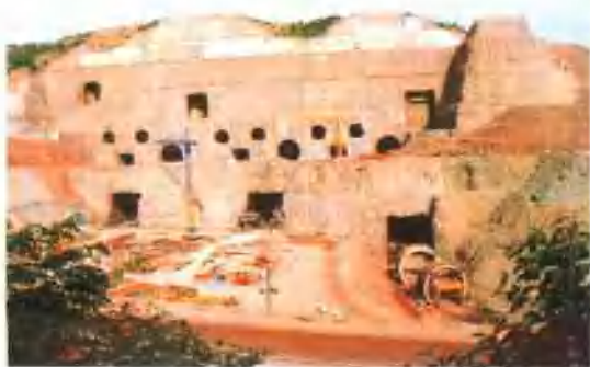
泄洪工程进水塔浇筑前洞群面貌
