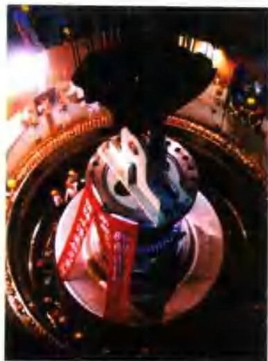
发电机转子吊装
