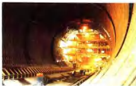
三套直径为14.5米的年能 回掘硬土衬砌采用刮板台车， 刮板台车一条龙施工
