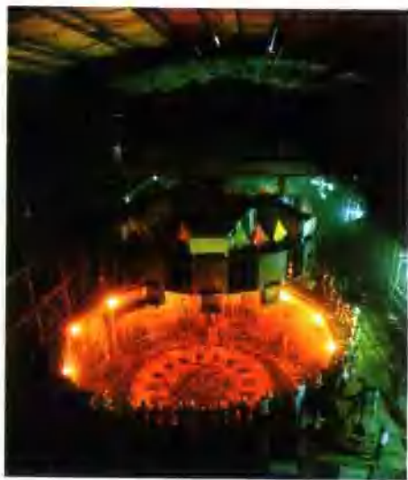
发电机定子吊装
