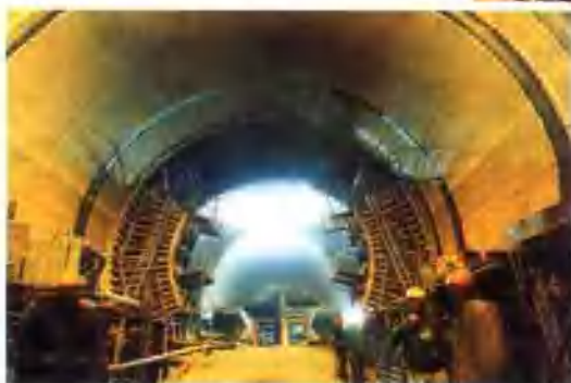
世界最大孔板衬砌洞的孔 板环施工
