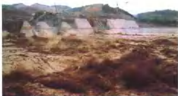
出水口泄洪时的磅礴气势
