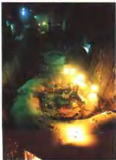
地下厂房机组铜壳焊接
