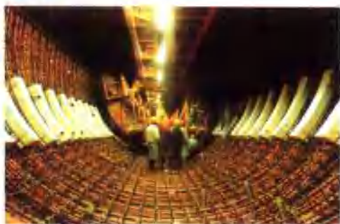
三套直径为14.5米的年能 回掘硬土衬砌采用刮板台车， 刮板台车一条龙施工
