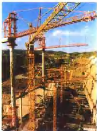
高度机械化施工
