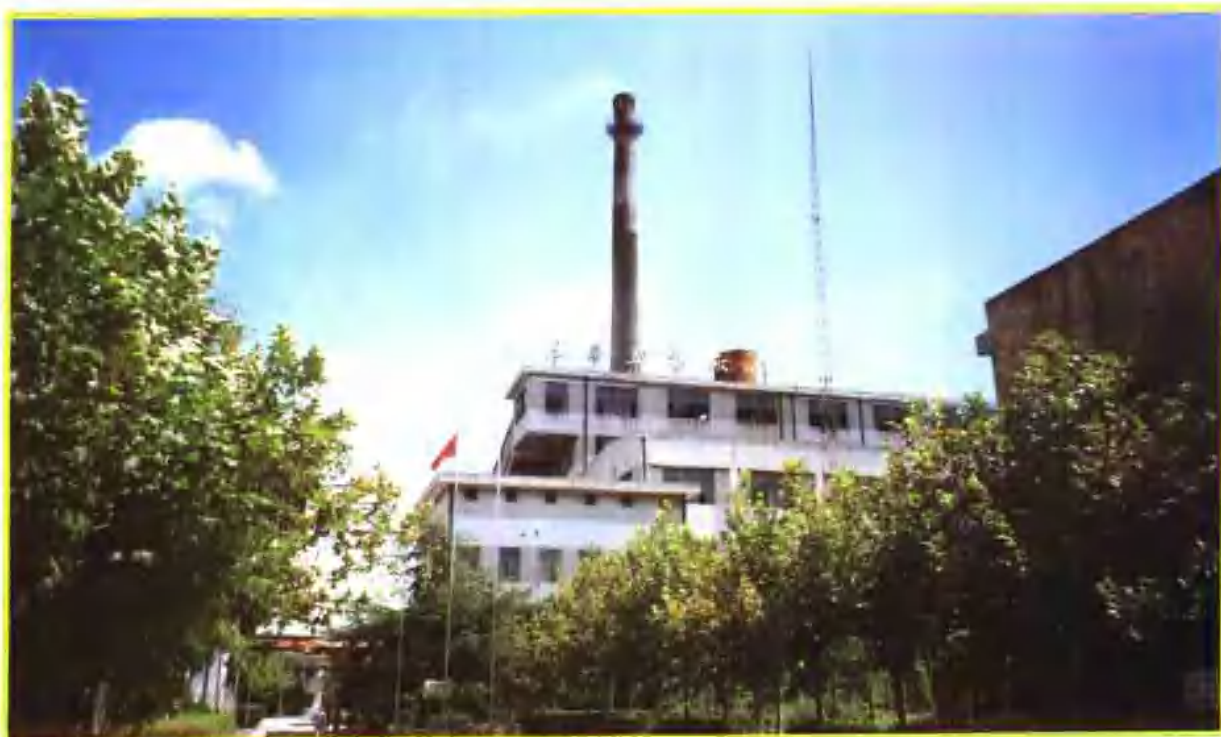
1989年建成发电总装机容量为10500千瓦的慈溪热电厂厂房
