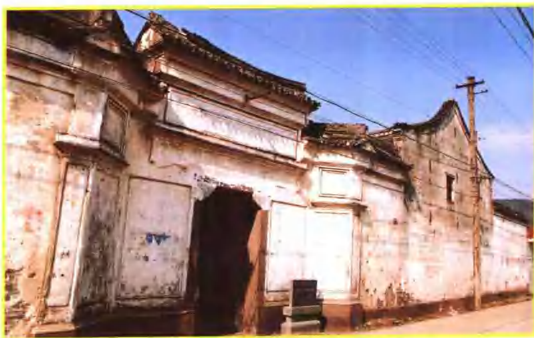
虞洽卿故居前低压线路
