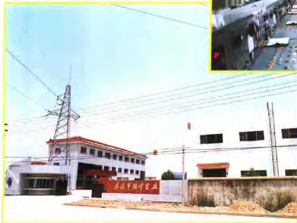
1994年8月建成发电的装机容量为1.25万千瓦慈溪调峰电厂
