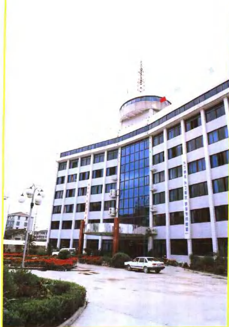
1993 年落成的 供电局电力大楼
